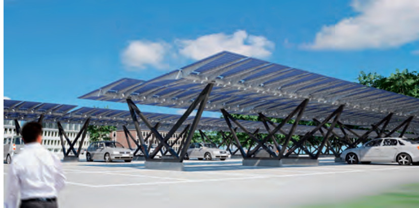
Solardächer auf den Firmenparkplätzen erzeugen Energie, die anschließend im Unternehmen verbraucht wird.
