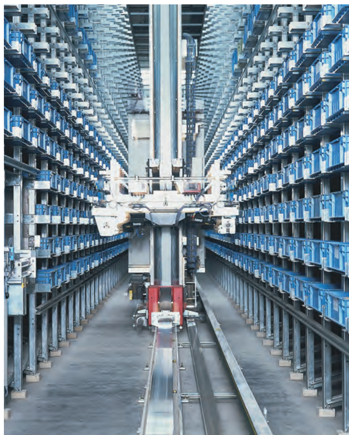
Effiziente Intralogistik eines Warenlagers Quelle: Lenze AG
