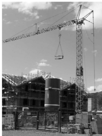
gru a torre con rotazione in basso
