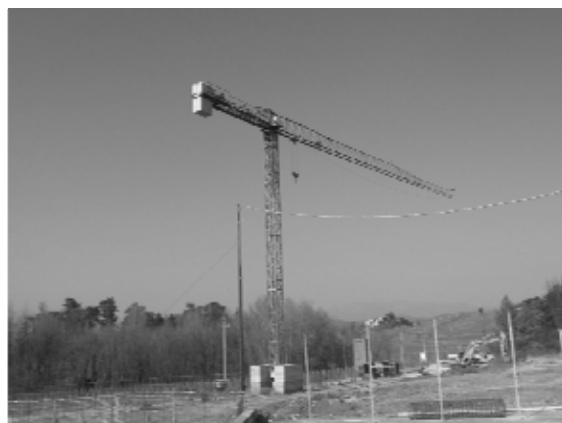
gru a torre con rotazione in alto
