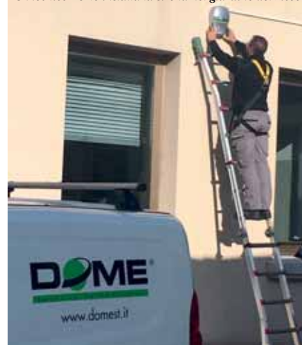
Un tecnico Dome installa la sirena nel giardino del Liceo
