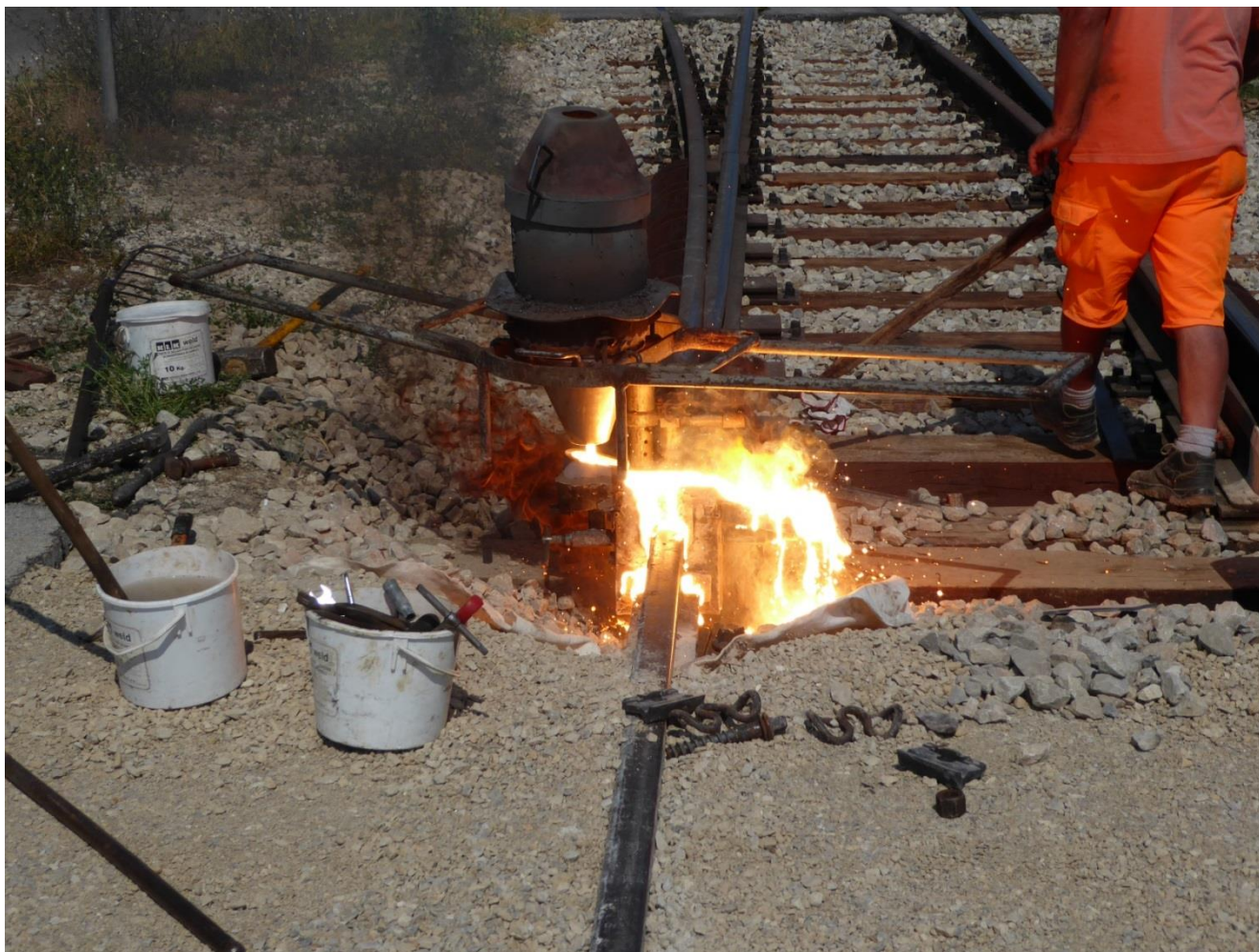
Saldatura alluminotermica delle rotaie
