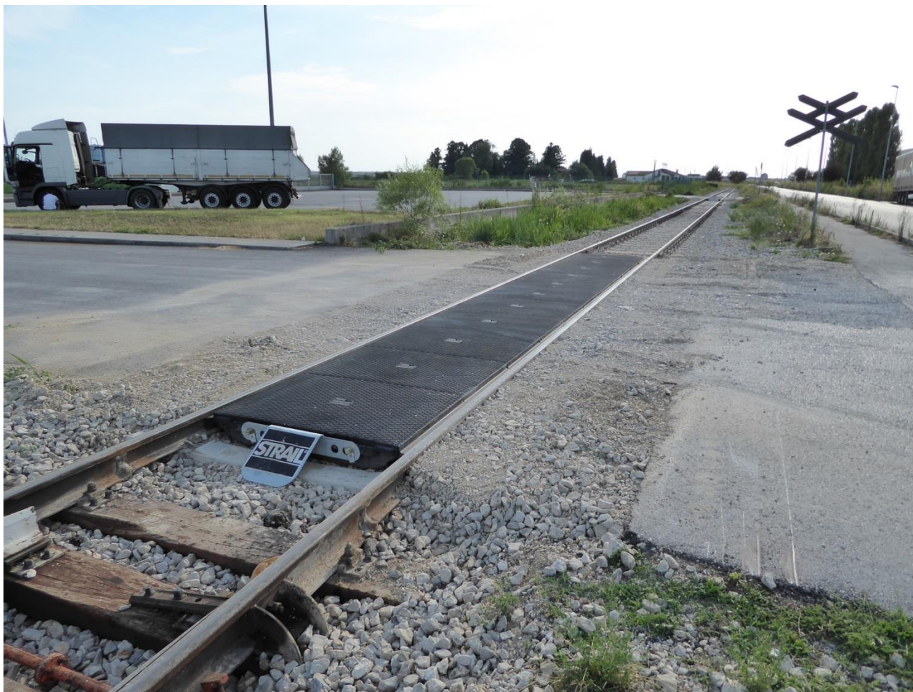
Rinnovo passaggio a livello con attraversamento «STRAIL»
