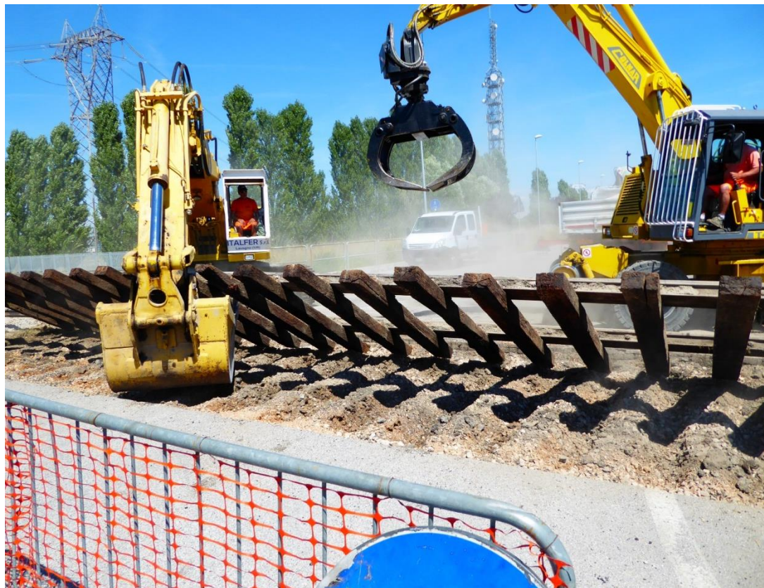
Rimozione vecchie campate di binario
