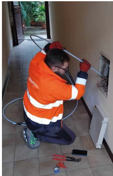
Il posizionamento della fibra ottica FTTH a Grado
